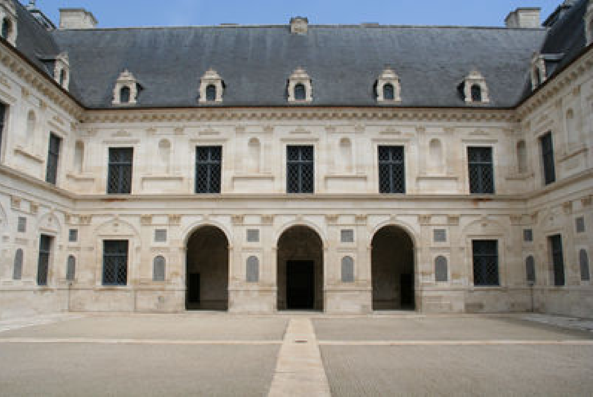
4 Ancy-le-Franc, château, la cour, 1538/46 (architecte : Sebastiano Serlio).
